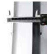
Parede com isolamento de 80 mm
