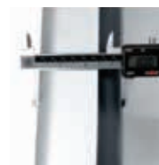
Parede com isolamento de 80 mm
