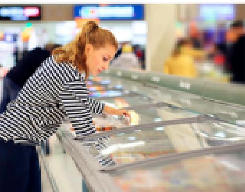
Estas temperaturas são alcançadas por meio de **refrigeração estática**, que ocorre através da condução de temperatura, entre as placas internas do equipamento e os produtos nele armazenados.
